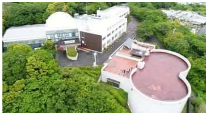
平成30年5月9日 ドローンによる撮影
