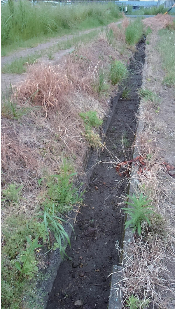
第1図. マルタニシの生息が確認された原川右岸側U字溝 (2018年1月)。
